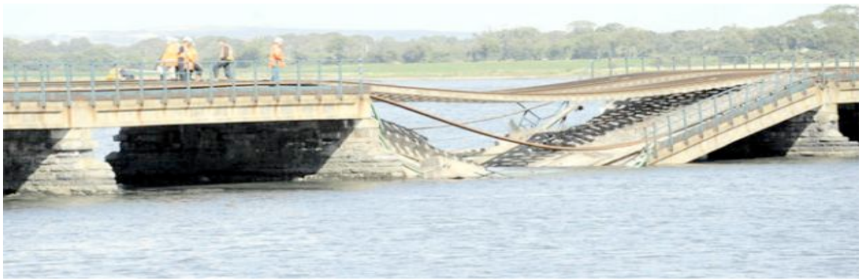
4. számú ábra: Vasúti híd összeomlása a Belfast–Dublin vonalon (2009. aug.) 299
